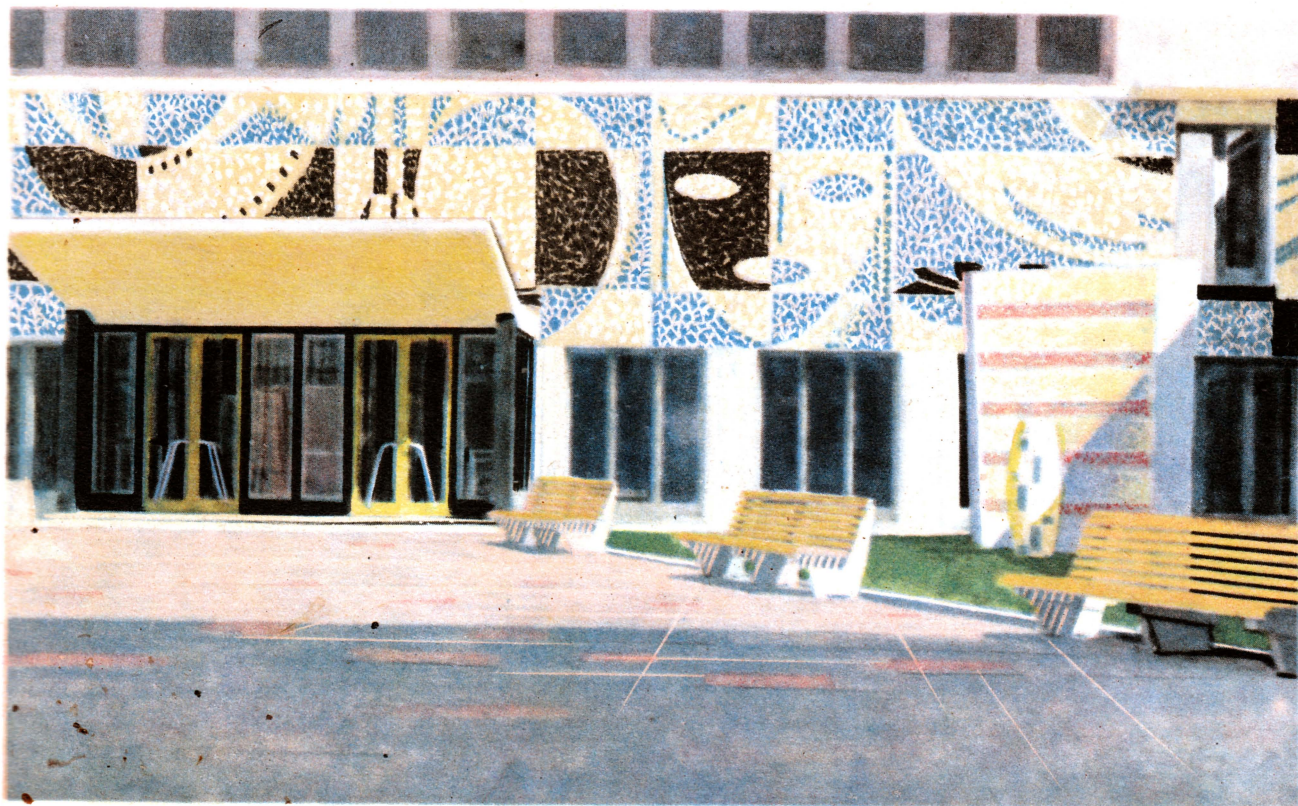
Мозаичная стенка внутреннего дворика Дворца культуры Белоярской атомной станции. Здесь использованы цветной цемент, уральские камни, нитроэмаль.
